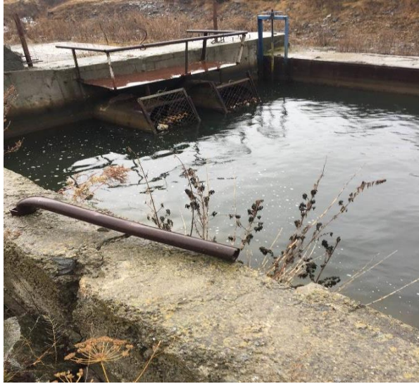
Նկ. 4.8. Իռիգացիոն թունելի (ճնշումային խողովակի) ելքամասում տեղադրված կառուցվածքների տեսքը
