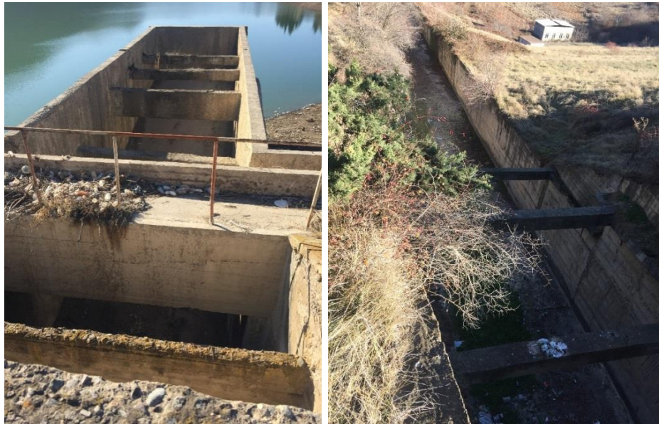
Նկ. 6.2. Աղետային բաց ջրի եռի գլխամասի և միջնամասի տեսքերը
