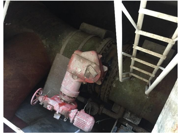
Նկ. 2.5. Իռիգացիոն ջրթողի սկավառակավոր և կոնական փականների տեսքերը
