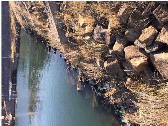
Նկ. 3.4. Պատվարի վերին շեպի խզվածքի տեղամասերի տեսքը
