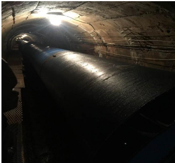
Նկ. 4.6. Իռիգացիոն թունելում տեղադրված D=1600մմ տրամագծի խողովակաշարի տեսքը
