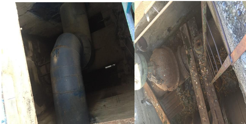
Նկ. 1.10. Պոմպակայանների սնուցման խողովակաշարի և դրա վրա տեղադրված կարգավորման փականի տեսքերը
