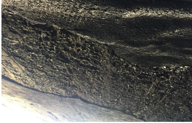
Նկ. 1.3. Իռիգացիոն թունելի վերջնամասի ե/բ երեսարկի տեսքը
