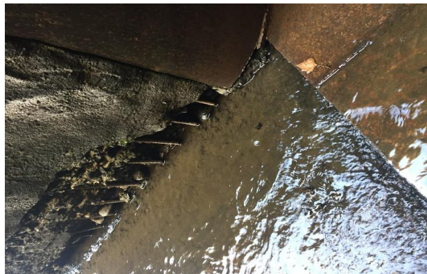
Նկ. 1.4. Իռիգացիոն թունելի թեք տեղամասի երեսարկի բացված ամրանների տեսքը
