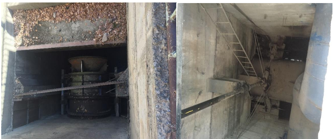
Նկ.1.8. Իռիգացիոն ջրթողի կոնական փականի և դրա ղեկավարման հիդրոմեխանիկական սարքավորման տեսքը
