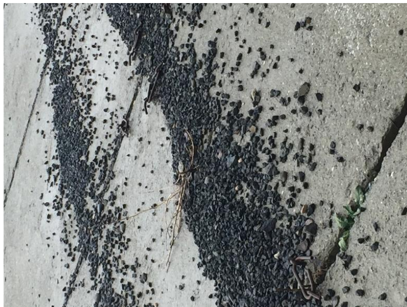
Նկ.4.1. Պատվարի վերին շեպի պաշտպանիչ ե/բ սալերի հակաֆիլտրացիոն կարերի պատկերը
