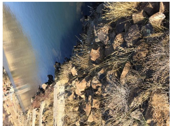
Նկ. 3.4. Պատվարի վերին շեպի խզվածքի տեղամասերի տեսքը
