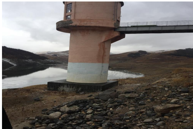
Նկ. 4.5. Իռիգացիոն ջրթողի փականային հանգույցի տեսքը
