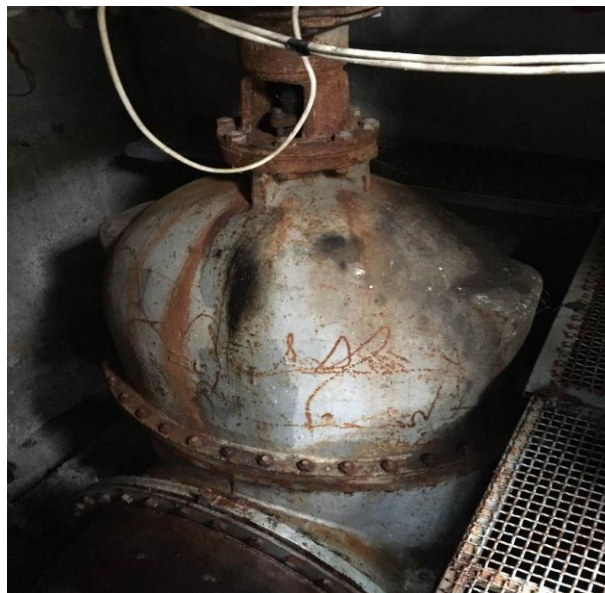
Նկ. 4.7. D=1600մմ տրամագծի իռիգացիոն խողովակաշարի կարգավորիչ փականի տեսքը
