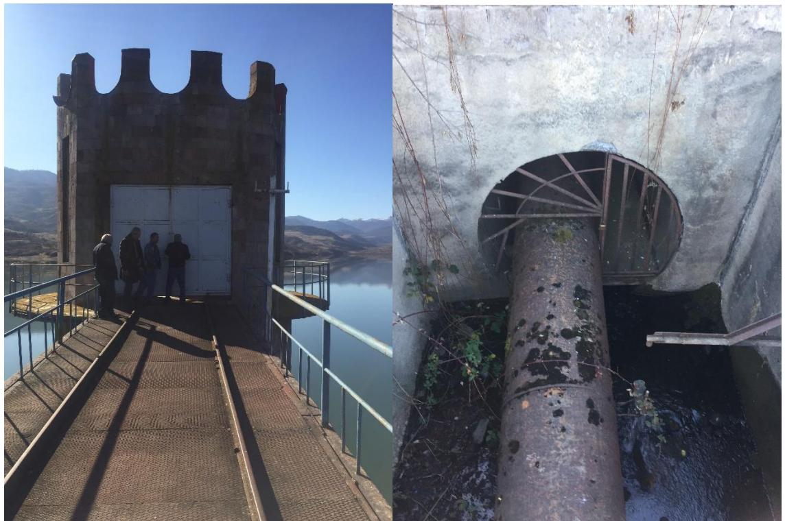
Նկ. 5.5. Աշտարակային ջրընդունիչի և իռիգացիոն ջրատարի տեսքը
