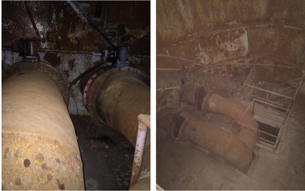
Նկ. 6.4. Իռիգացիոն ջրթողի մոտեցնող խողովակների և սկավառակավոր փականների տեսքերը
