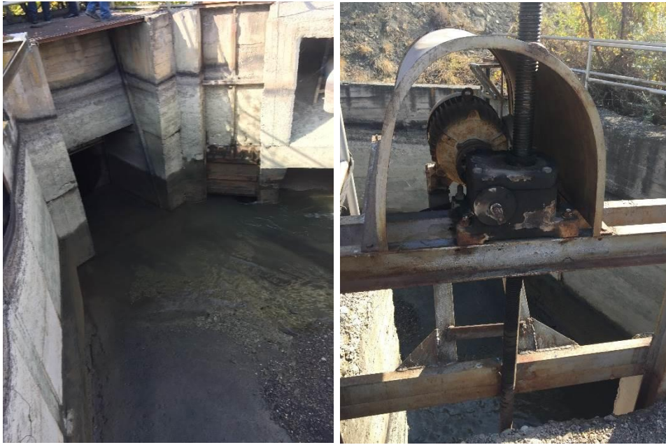
Նկ. 2.7. Իռիգացիոն ջրթողի բաժանարար հանգույցի և դրանում առկա հիդրոմեխանիկական սարքավորումների պատկերը
