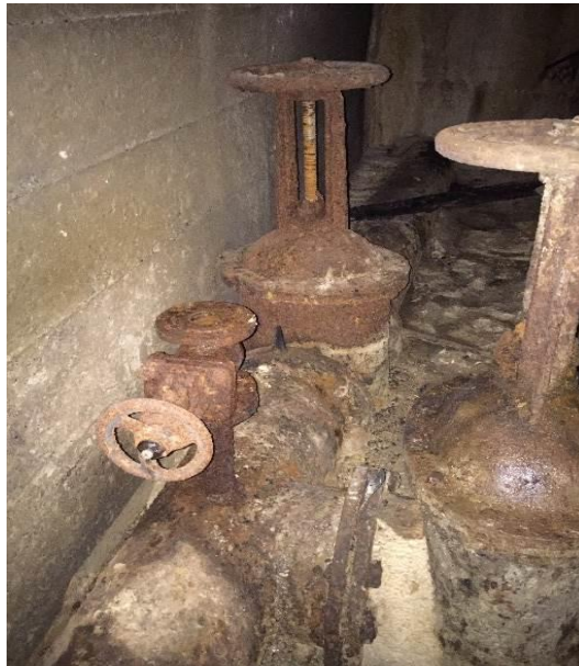
Նկ. 2.5. Ջրամբարի դատարկման խողովակաշարի և դրա վրա տեղադրված կարգավորման փականների վիճակը
