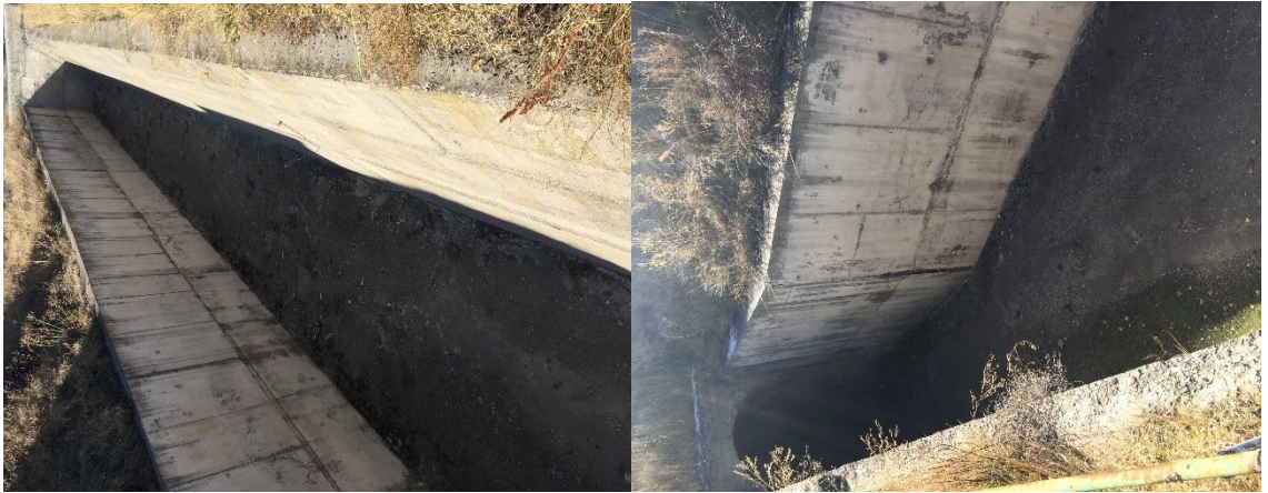
Նկ. 1.7. Աղետային ջրհեղի մուտքի բաց տեղամասի և թունելի մուտքի տեսքերը
