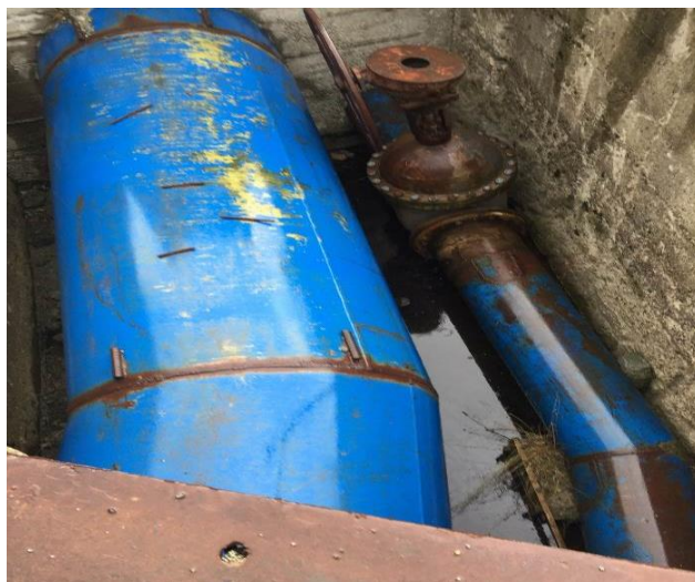
Նկ. 4.9. Ջրամբարի դատարկման խողովակաշարի և դրա վրա տեղադրված
