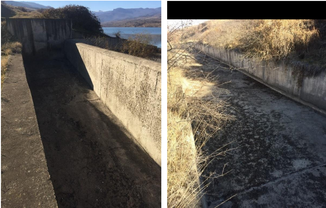
Նկ.5.4. Աղետային բաց ջրհեռի վերջնամասի և միջնամասի տեսքերը
