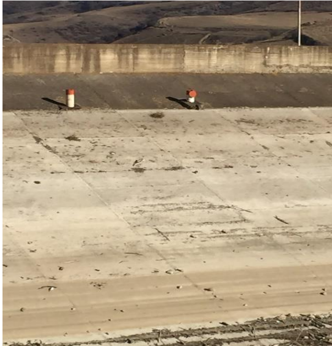
Նկ. 6.1. Պատվարի մարմնում տեղադրված այեզոմետրի արտաքին տեսքը
