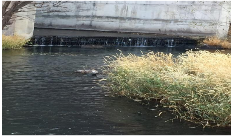
Նկ. 3.7. Աղետային ջրհեռի վերջնամասի և մարիչ հորի տեսքը
