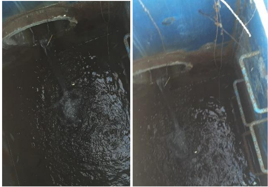
Նկ. 5.1. Ներքին շեպում ֆիլտրացիոն հոսքերի մասնակի, հավաքագրման զույգ տեղամասերի տեսքերը
