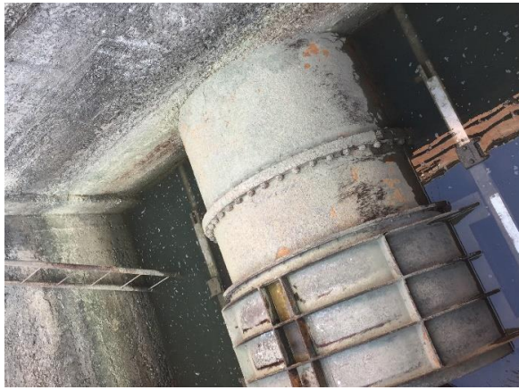
Նկ. 2.5. Իռիգացիոն ջրթողի սկավառակավոր և կոնական փականների տեսքերը
