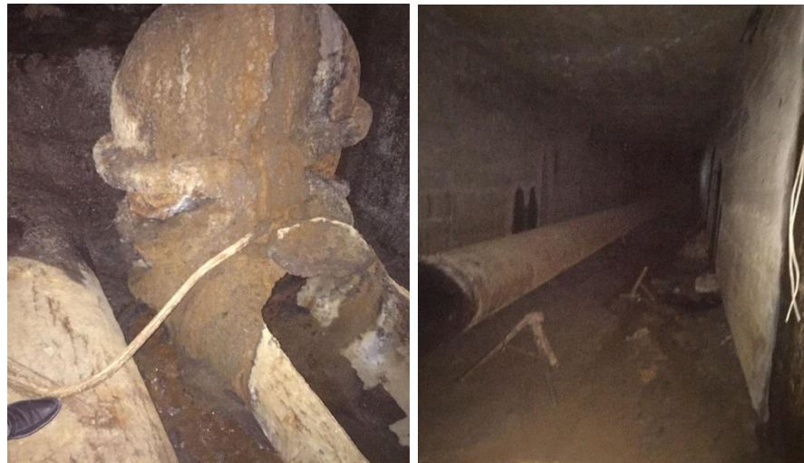
Նկ. 6.3. Ջրամբարի դատարկման խողովակաշարի և դրա վրա տեղադրված կարգավորման փականների տեսքերը
